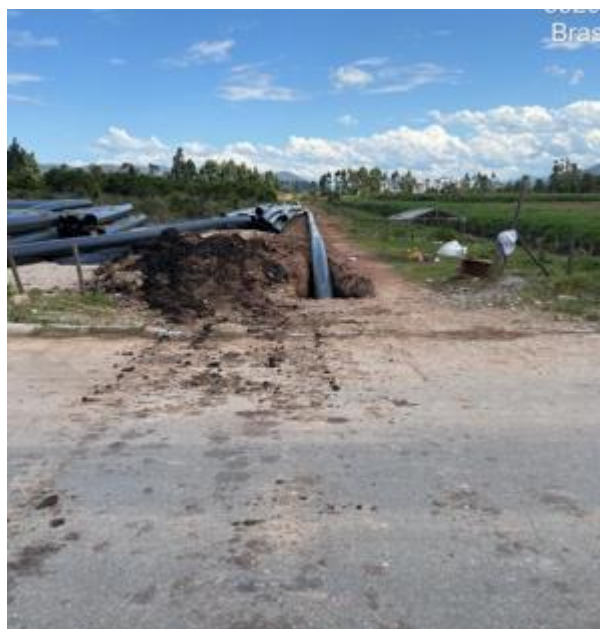
Figura 4 – execução de nova adutora em PEAD.
