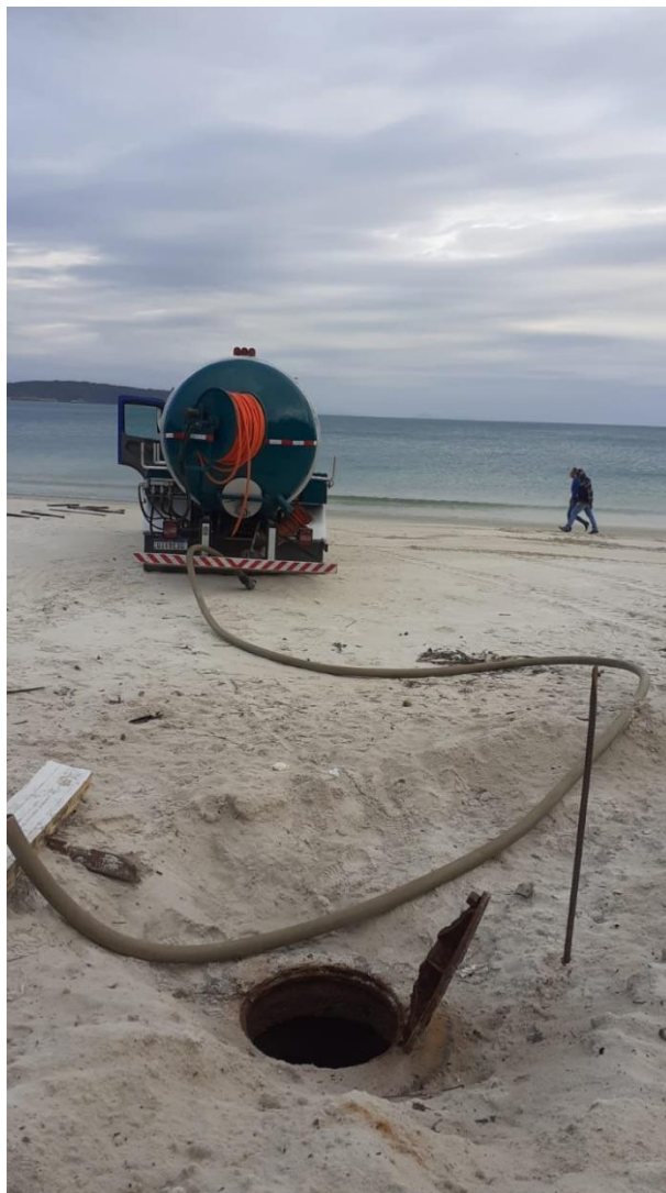
Figura 13 - Preparação para limpeza de rede.
