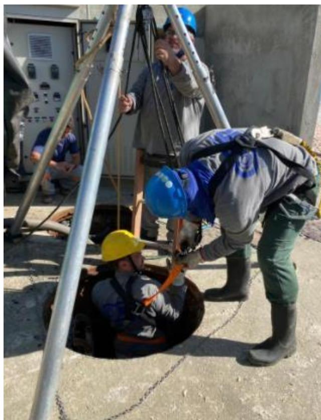
**Figura 13: Manutenção e limpeza das válvulas da EE01.**
