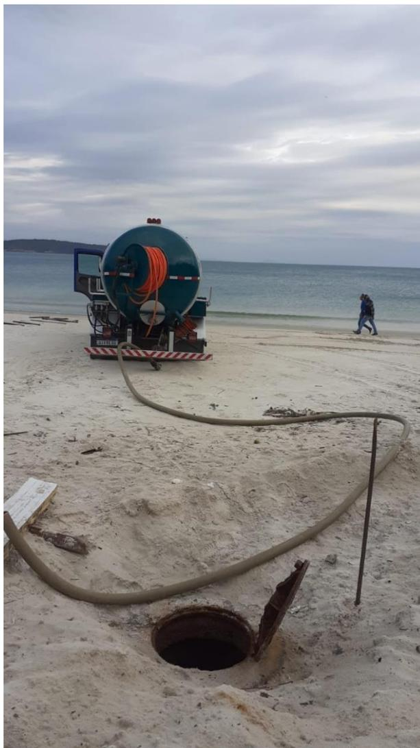
**Figura 15 - Preparação para limpeza de rede.**
